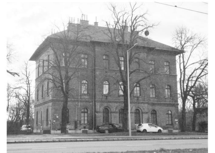
Kerepesi út 81. - TERVEZETT HELYSZÍN
